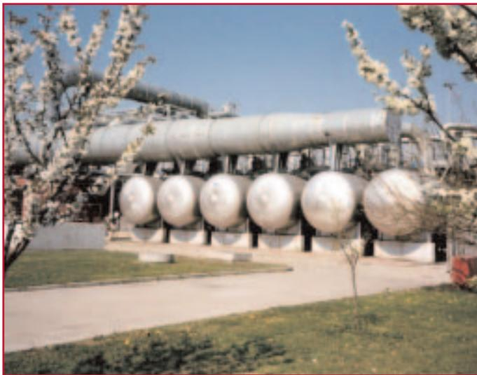
Fig. 3 - Impianto di recupero solventi, con capacità di 300.000 Nm<sup>3</sup>/h
