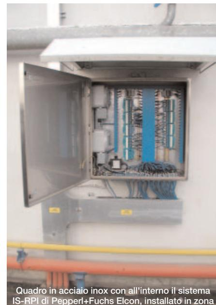
Quadro in acciaio inox con all'interno il sistema IS-RPI di Pepperl+Fuchs Elcon, installato in zona
