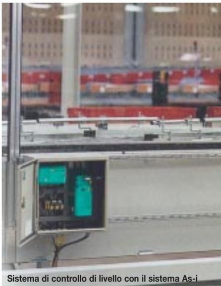
Sistema di controllo di livello con il sistema As-i
