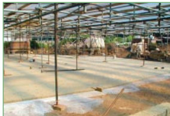
Fig. 7 - Una fase dei lavori di impermeabilizzazione svolti sul Colle Oppio a protezione della Domus Aurea. Sono stati impiegati mattoni crudi e sottili materassini di bentonite
