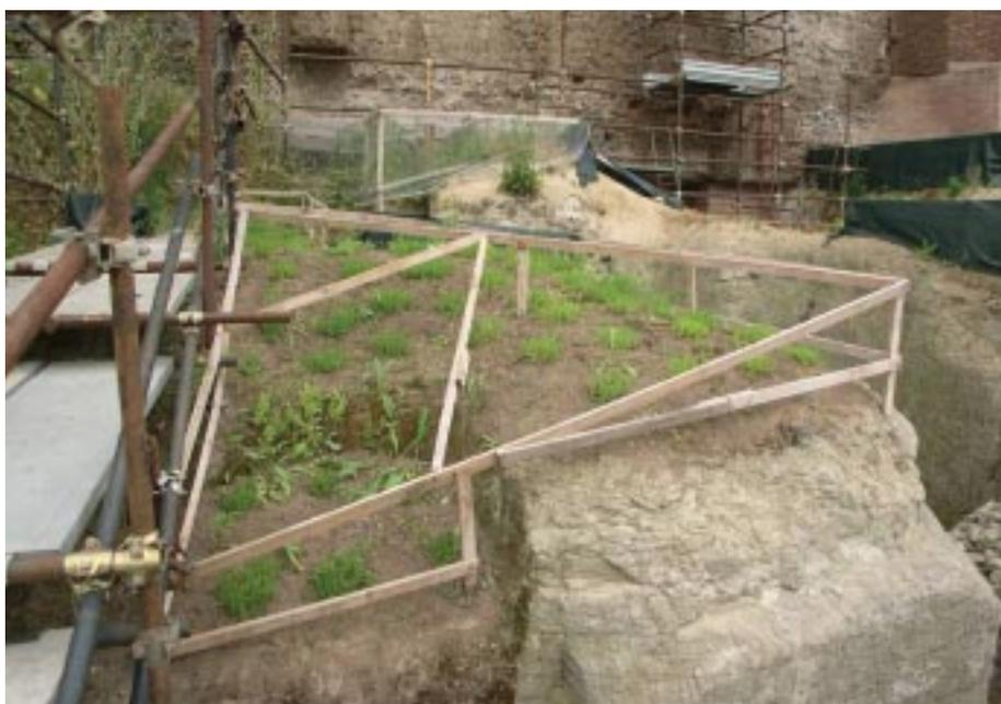
Fig. 5 - Una porzione del colle Palatino trattata con silani fluorurati formulati dal CISTeC. Su una porzione trattata si è anche seminato un tappeto erboso supportato da un piccolo spessore di terra
