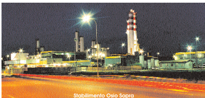
Stabilimento Osio Sopra
