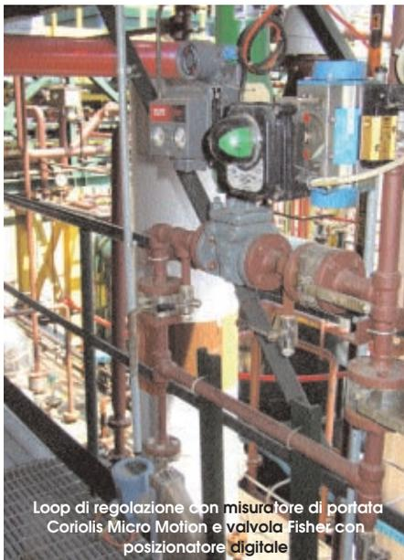
Loop di regolazione con misuratore di portata Coriolis Micro Motion e valvola Fisher con posizionatore digitale
