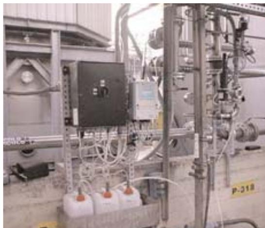
Tutte le funzioni dello strumento, per esempio l'avvio, la calibrazione e i programmi di pulizia, sono attuabili attraverso il pannello di controllo tramite la semplice pressione di un bottone. Per la registrazione dei valori misurati, il sistema può essere dotato dello strumento MemoGraph.
