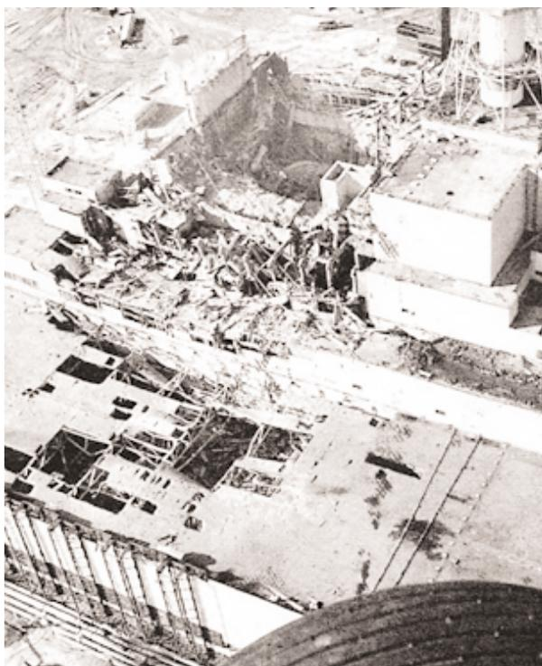
Figura 4 - Vista del reattore RBMK esploso a Chernobyl prima della costruzione del sarcofago
