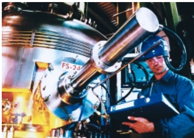
Essiccatore a filtro da 5 m 3 nell'impianto della Novochem 2000 a Murcia (Spagna)
