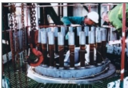
*Tubi Safurex forniti per il condensatore di carbammato ad alta pressione installato nello stabilimento di produzione di urea Police Zakłady Chemiczne in Polonia*
