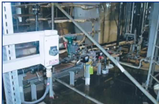
Particolare valvola di regolazione con posizionatore intelligente Fieldbus Foundation
