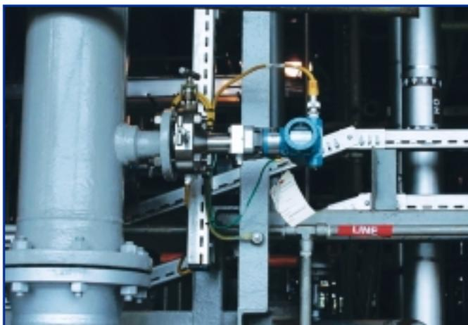
Particolare strumento di pressione Fieldbus Foundation
