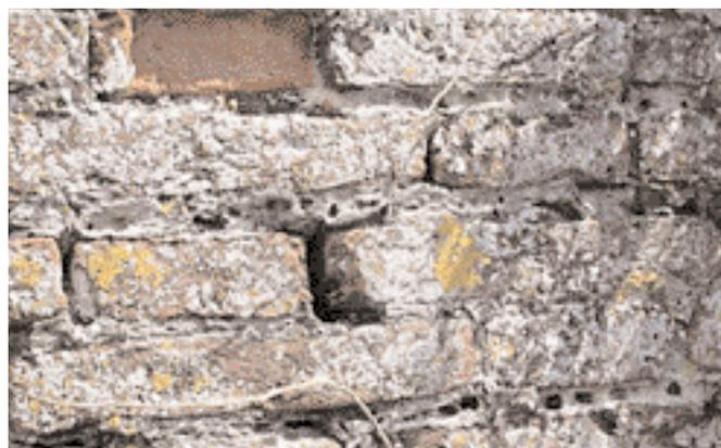
Figura 5 - Mura di Terra del Sole: particolare dei conci sottoposti a degrado
