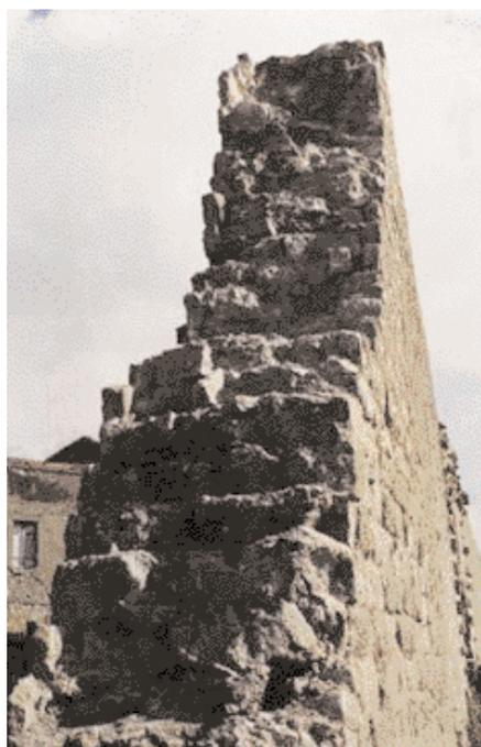
Figura 3 - Mura Civiche di Viterbo: veduta dell'interno della muratura eseguita con la tecnica "a sacco"
