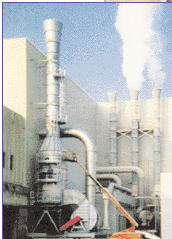
Figura 6 - Impianto di abbattimento polveri ad umido prodotte da atomizzatore nell'industria ceramica
