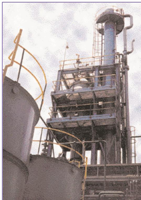
Scarico zero: impianto di evaporazione
