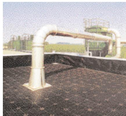
*Biofiltri realizzati con pareti di contenimento modulari*
