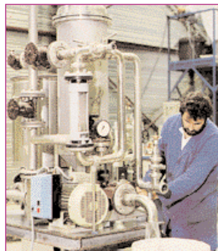
Fase di ottimizzazione di impianto di filtrazione studiata dall'Ifs
